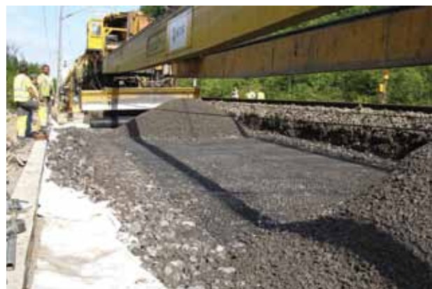
Tensor TriAx® stabiliseringsgeonett lagt under det granulære forsterkningslaget for å øke bæreevnen (Belgia).
