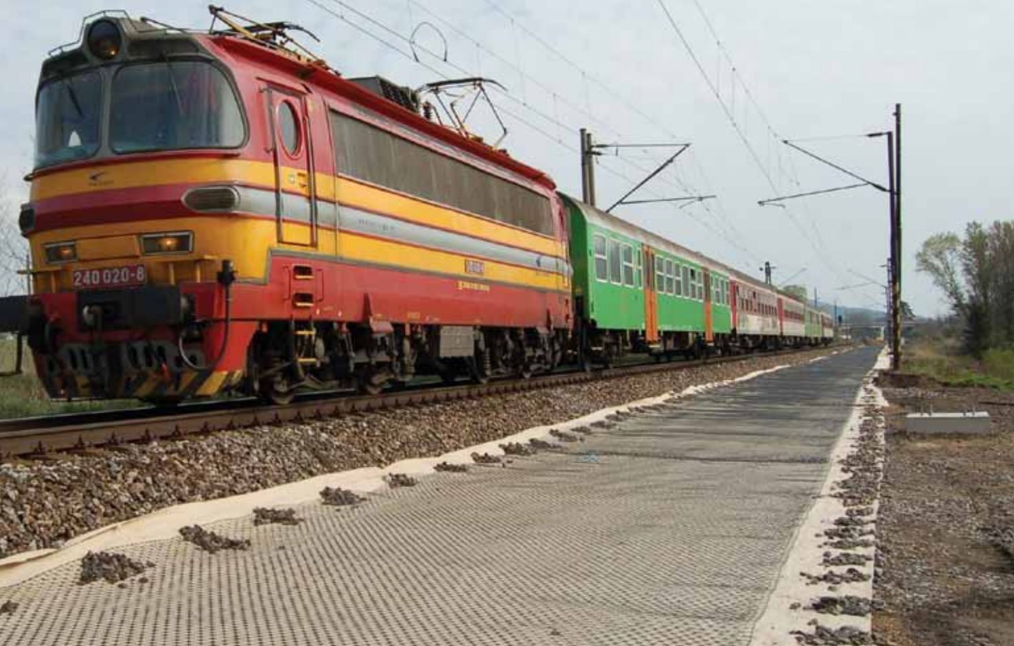
Rehabilitering av jernbane over en undergrunn med lav bæreevne ved bruk av mekanisk stabilisert forsterkningslag, (Bratislava, Slovakia).
