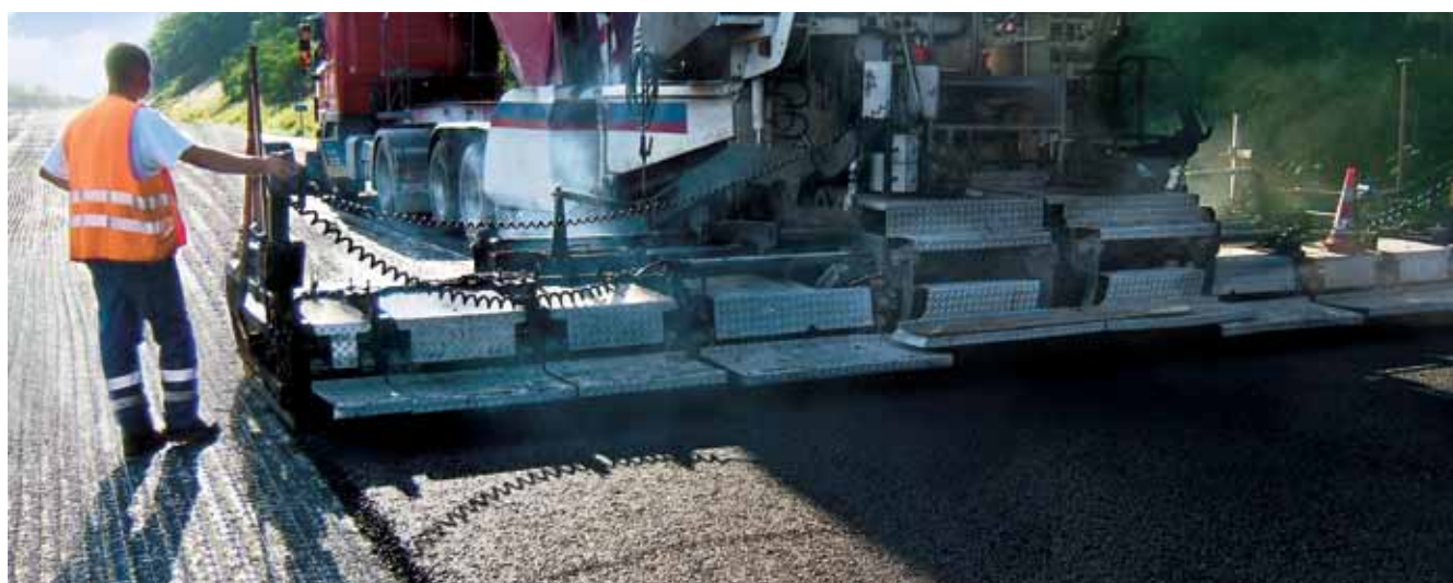
Dekke blir lagt direkte over Tensor AR-GN.
