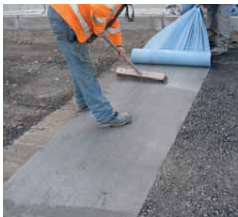
Glasstex®Patch™ 880 kan bli brukt til de fleste faste dekker på grunn av klebemiddelbelegget.
