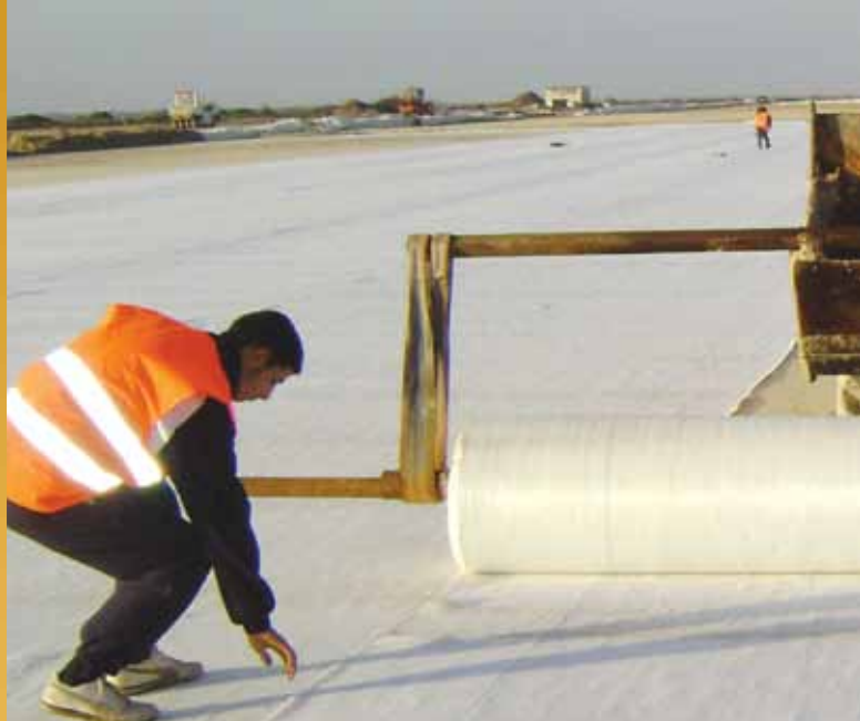
Tensar® Basetex™ geotekstil installasjon på Oran flyplass i Algerie som ga en kostnadseffektiv installasjon og i tillegg ga en permanent solid forsterkning under fyllingen.
