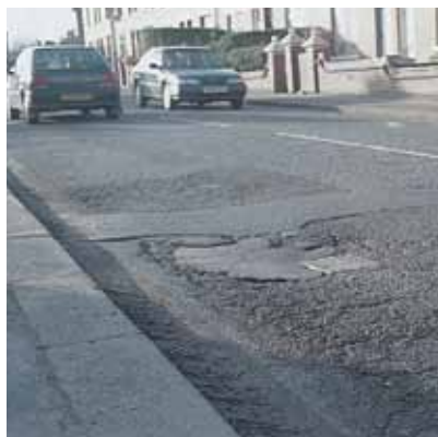
Vanlige strukturelle dekkeproblemer, spordannelse, utmattings- og refleksjonssprekker.
