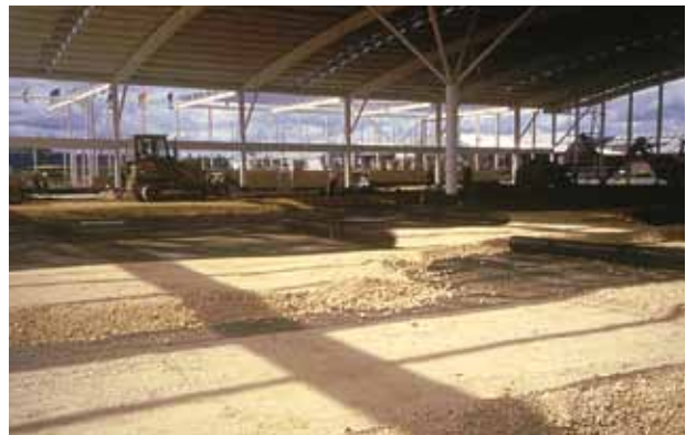
LTP under betongplate, ifm konstruksjon av bygg med stålramme (UK).
