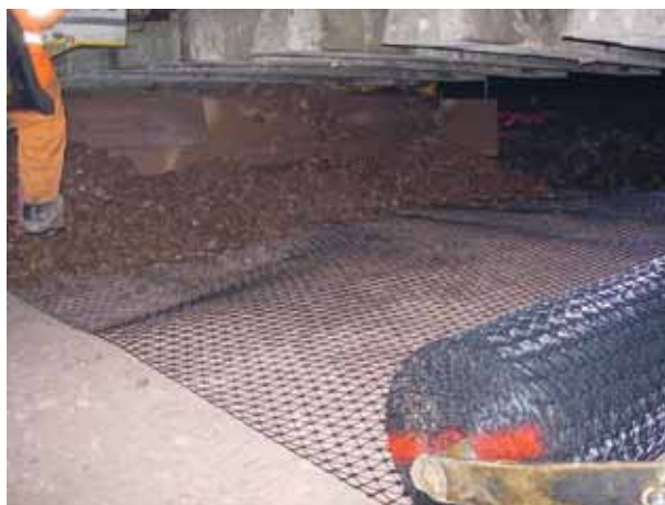
Installasjon av stabiliseringsgeonett i ballasten (Belgia).
