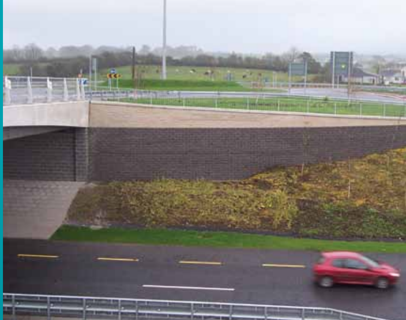
TensarTech Wall Systemer - forskjellige farger er benyttet på fasadesteinene for å en tydelig effekt på vingemuren til brua.
