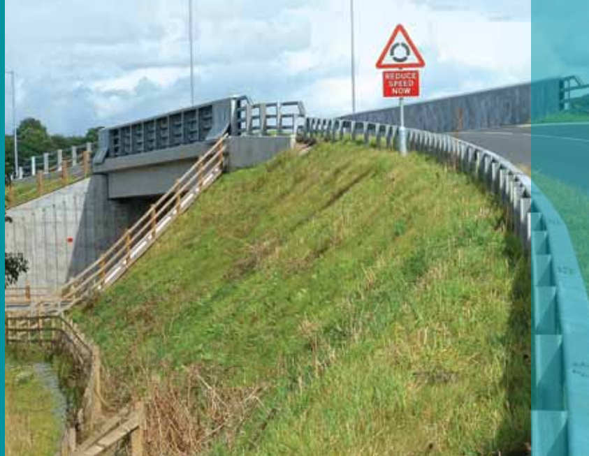
TensarTech Systemer for skråninger med Jordarming forkorter byggetiden og har minimal effekt på trafikkavvikling.
