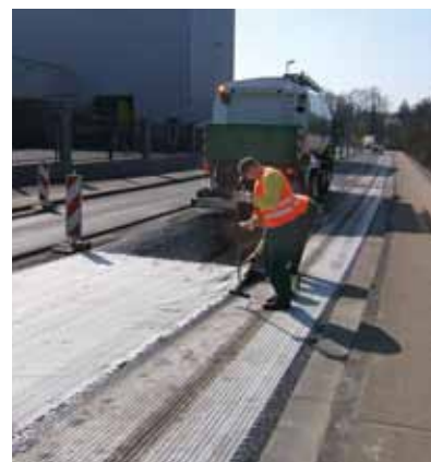
Enkelt overlapp ved påføring av Tensor Glasstex.
