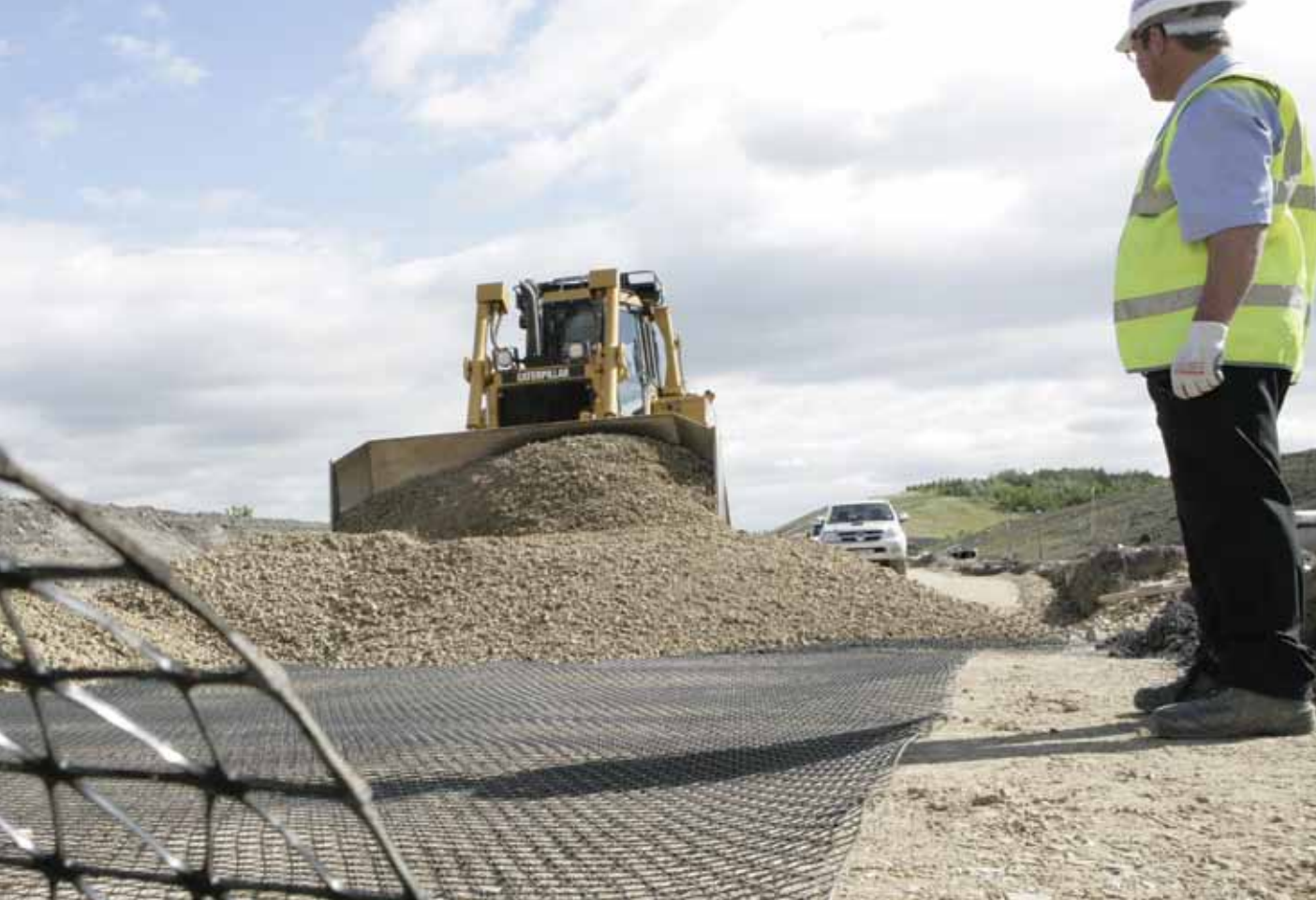
TriAx® gir steinmaterialene bedre fordeling og låsing, som vil øke den strukturelle funksjonen til det mekanisk stabiliserte laget.
