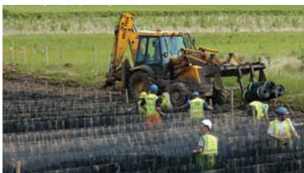
TensarTech® Stratum® Fundamentering med Geocellesystem.
